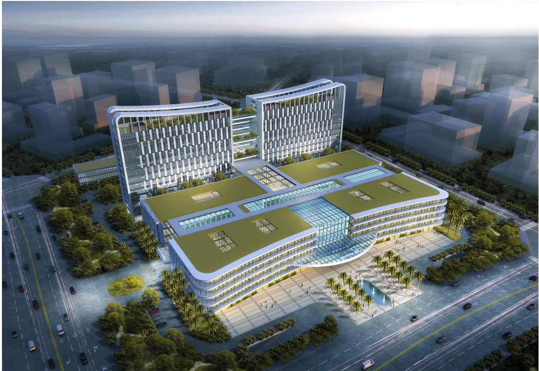
(在建中的新院区)
